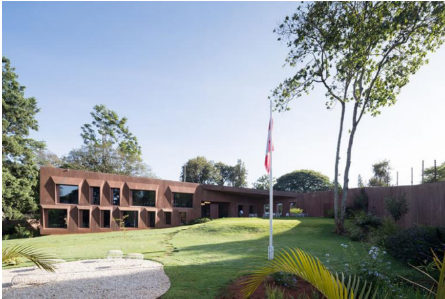
Herauswachsen des Gebäudes aus der Umfriedung. Bild: Iwan Baan
